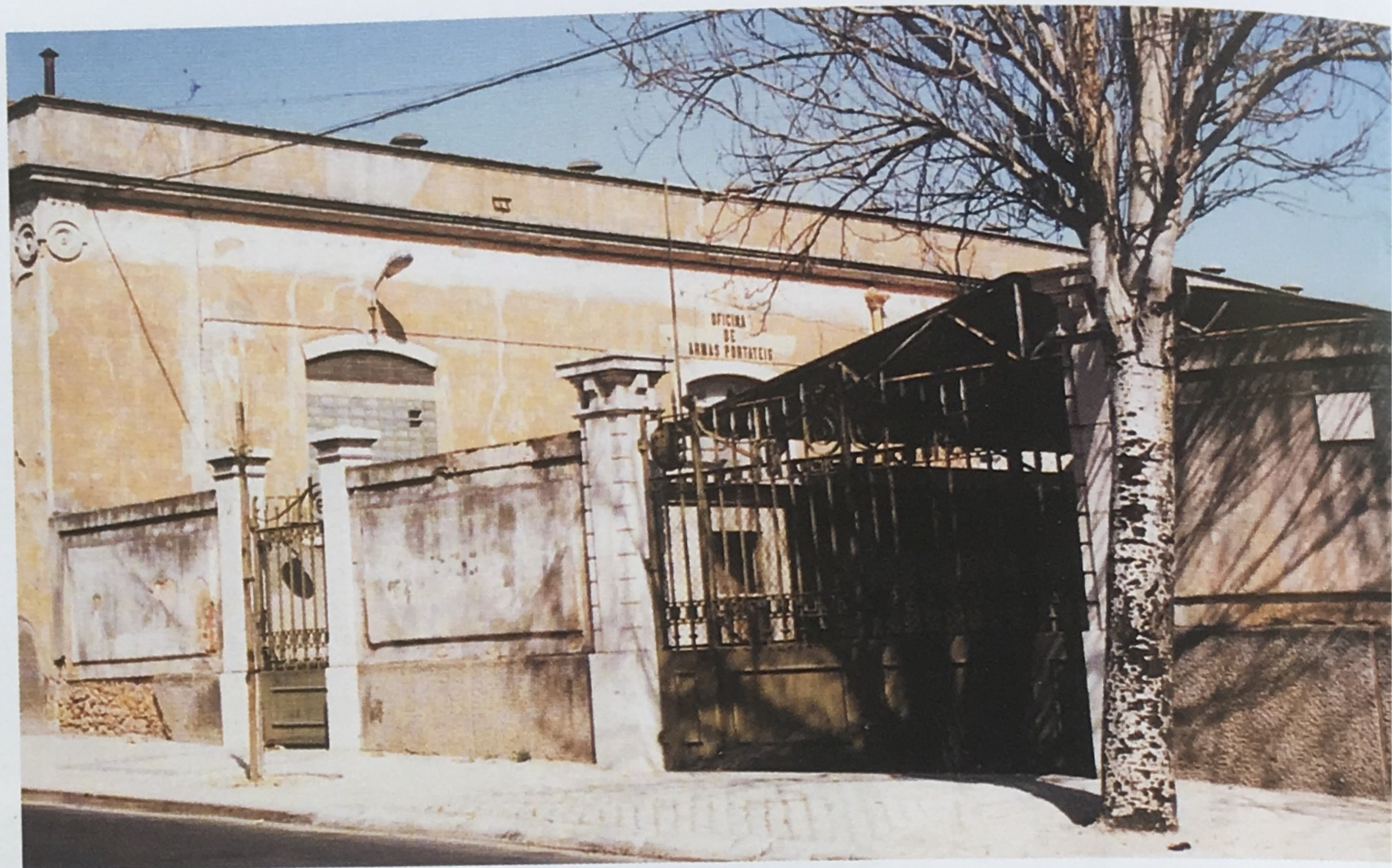
> Fábrica de Material de Guerra de Braço de Prata, no Poço do Bispo
